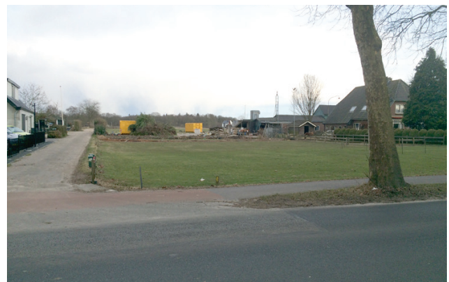
Rubensstraat: situatie na sloop
